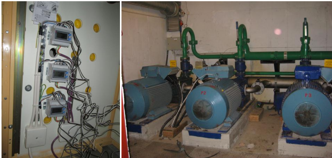
Figur 19: 3st EM21 mäter energi och effekt på högtryckspumpar.
