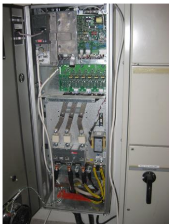
Figur 6: tilltänka installationspunkter för strömtrafos.
