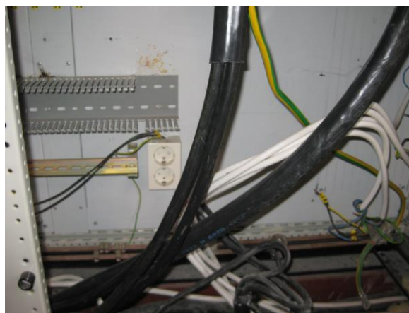
Figur 6: tilltänka installationspunkter för strömtrafos.
