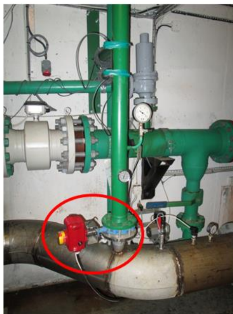
Figur 48: Den befintliga manuella regleringen på kylvatten.
