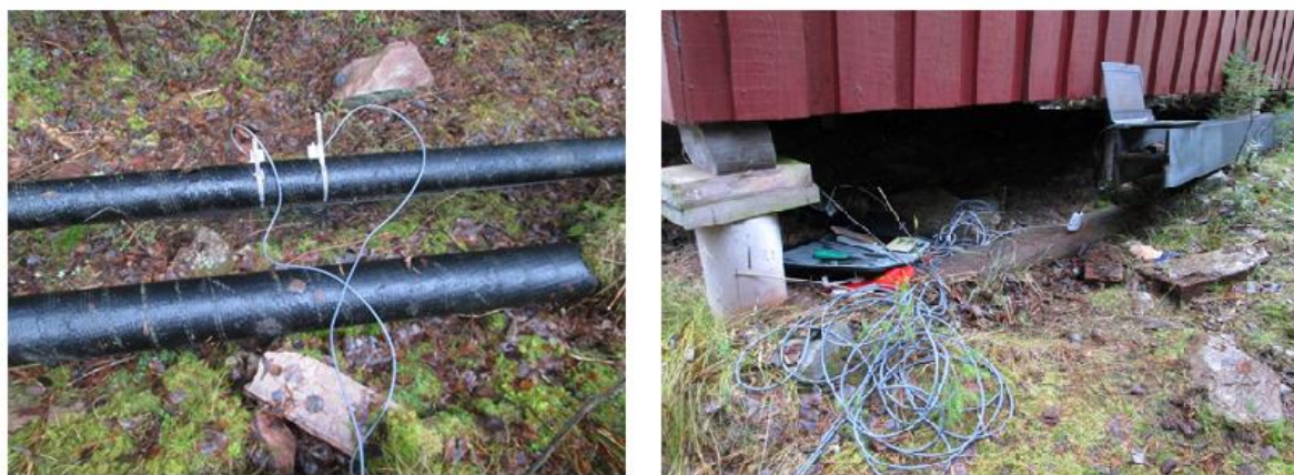
Figur 54: ultraljudssonder på rören (t.v.) & loggningsinstrument samt avläsning i datorn(t.h.)
