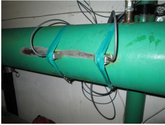
Figur 25: ultraljudflödesmätning på vatten rör (trycksida och kylvatten).
